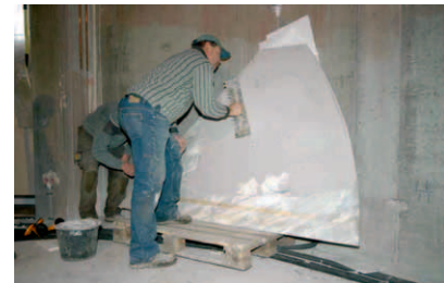
Vorgefertigte Elemente mit Granirapid, rückseitig aufgetragen als Haftbrücke
