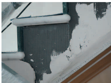
Verlegung einer Wedi-Platte an den Treppenwangen, um Risse zu vermeiden
