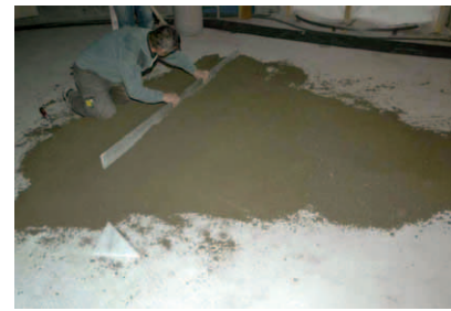
Einbringen des Verlegemörtels aus Mapecem auf einer Haftschlämme, hergestellt mit der Emulsion Planicrete
