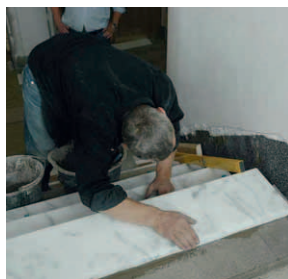
Verlegung der Setz- und Trittschalen mit Mapestone 1
