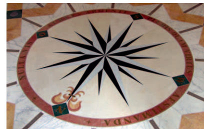
Stern aus acht vorgefertigten Elementen
