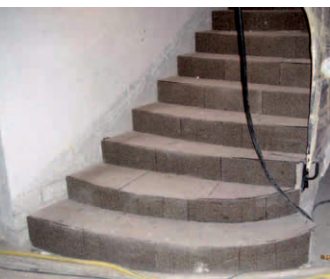
Einbau des Trittschallsystems Mapefonic
