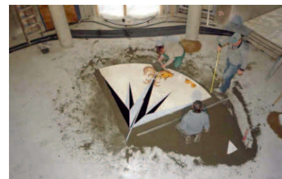
Verlegen der Elementplatten
